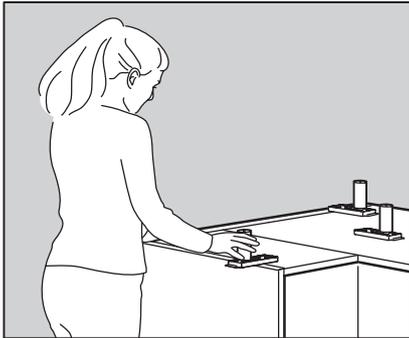
Zuerst werden die Unterschränke entsprechend der beiliegenden Montageanleitung montiert. Mit der Anbringung von Schubladen, Türen und Inneneinrichtung solltest du aber noch warten.
